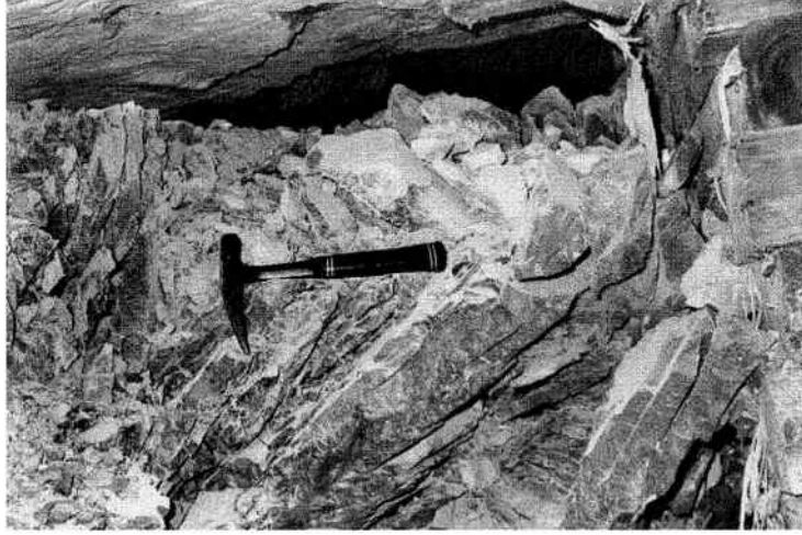
Şekil 49. Carleton altın ocağında kaya patlaması (Ortlepp ve Stacey, 1994).
