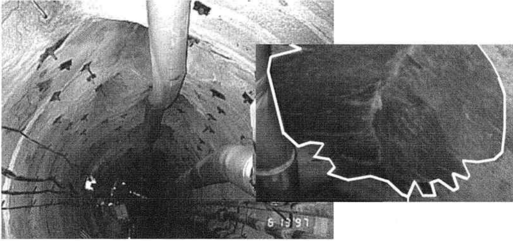
Şekil 45. Kaya patlaması lokasyonlarından görüntüler (Lee vd., 2004).
