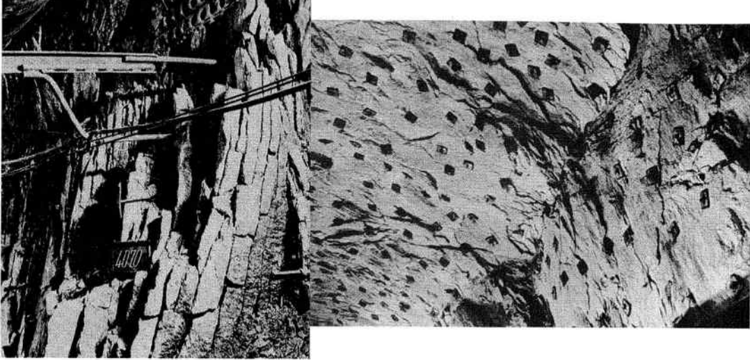
Şekil 28. Mont Blanc tüneline oluşan kavlaklanmadan görüntüler (Panet, 1969).
