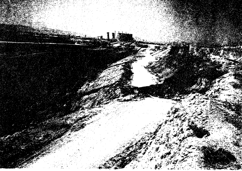
Şekil 1. Kışlaköy İşletmesi Kuzeybatı Şevinde Meydana Gelen Kaymadan Bir Görünüm.
