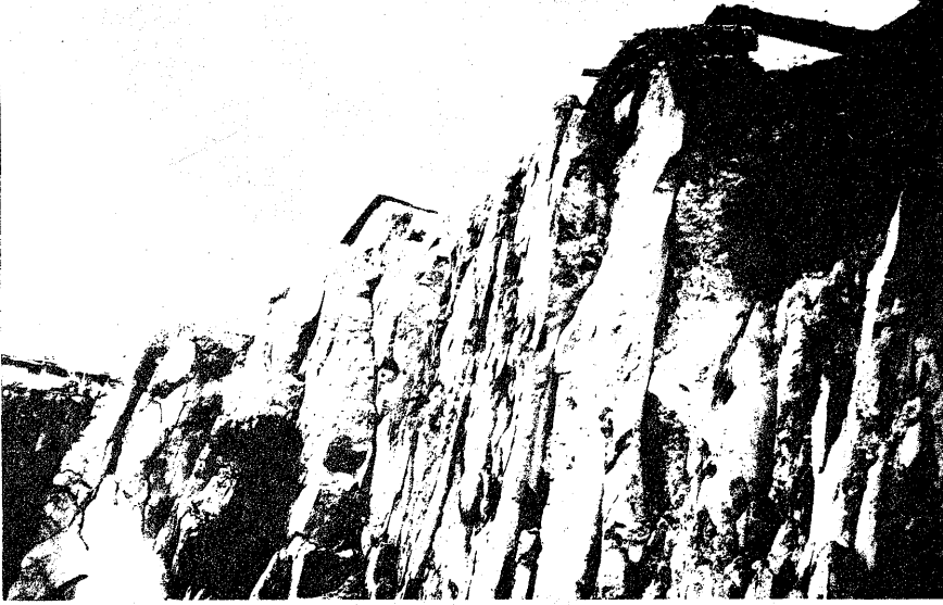
Şekil 4. Andezitlerde düşü ynde geliřmiř soğuma atlakları (Altındağ)
