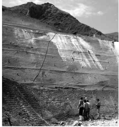
Şekil 5. Sefaköy Barajı gövde kazısı şevlerinde donatılı kaya uygulaması.
