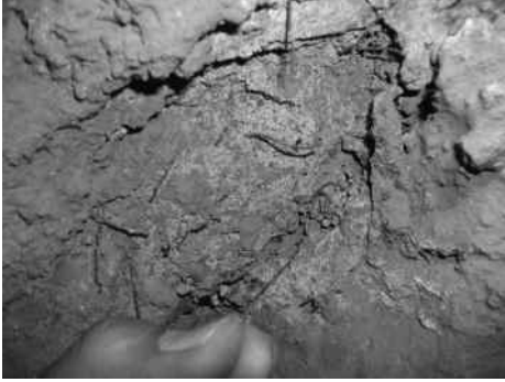
Şekil 1. El ile koparılabilen paslanmış çelik fiberler
