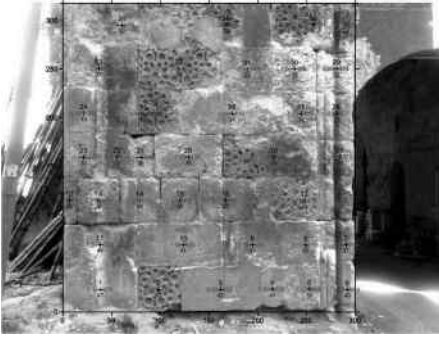
Şekil 3. Ölçüm yapılan cephe ve ortalama Ultrasonik hız, Schmidt ve Equotip sertlik değerleri.
