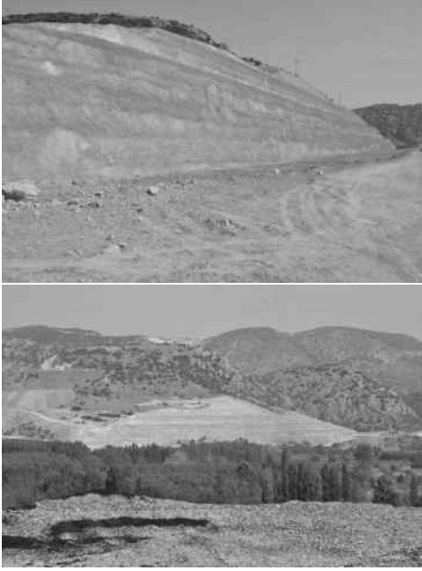
Şekil 9. Bilecik istasyon bölgesi şevlerinin tamamlanmış hali.
