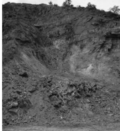
Şekil 9. Kama türü kayma yüzeyinin duraysız kütle temizlendikten sonrası görünümü.
