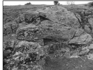
Şekil 13. T6/7/8 tüneli çıkışı portalı yakınında gözlenen tuf mostrası.
