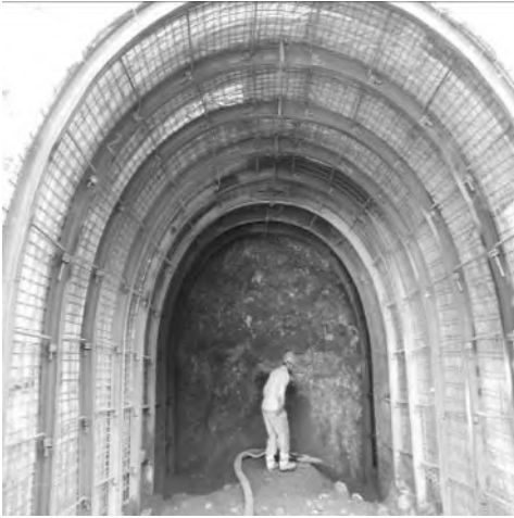
Şekil 8. Orta sağlam kayada kullanılan tahkimat elemanları (Turan, 2013).
