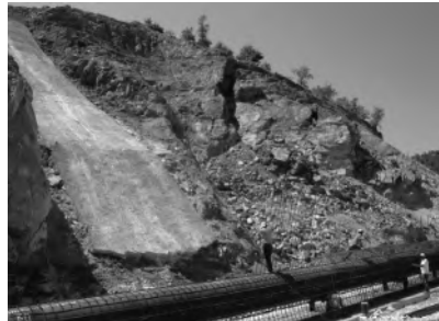
Şekil 10. Kama türü kayma yüzeyinde meydana gelen düzlemsel kaymanın görünümü
