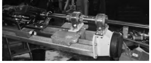
Şekil 8. Yarı mekanize uygulama (Yer delici makinası ile)
