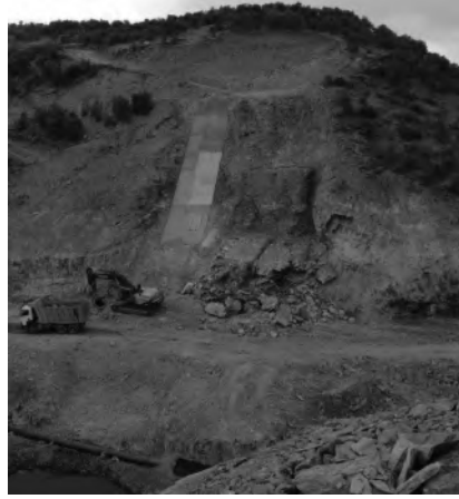
Şekil 8. Güllübağ göleti sağ sahilinde aktarma tüneli temel kazısı sırasında meydana gelen kama türü kaymanın başlangıç aşaması.
