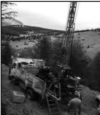
Şekil 14: T-5 Tüneli SK-123+126 no'lu sondaj
