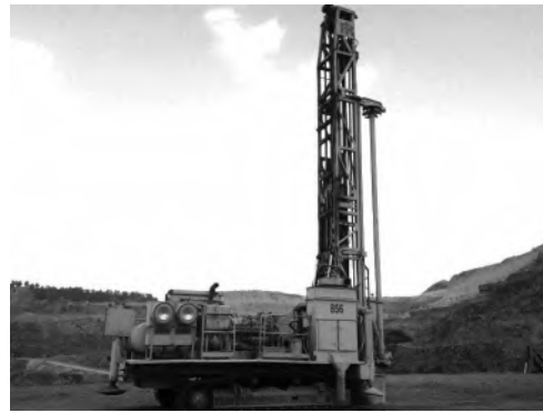
Şekil 2. DM50 sondaj makinası'nın genel görünümü
