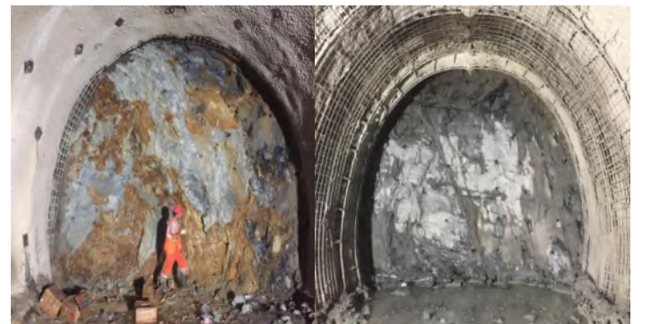
Şekil 5. Sağ hat km 0+525.40 ve sol hat km 0+466.20 tünel aynalarında Dolayoba Kireçtaşı'nın görünümü ve uygulanan kazı destekleme sistemi.
