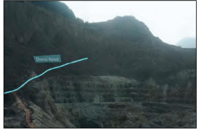
Şekil 5. Ocak alanında yapılan drenaj kanalı
