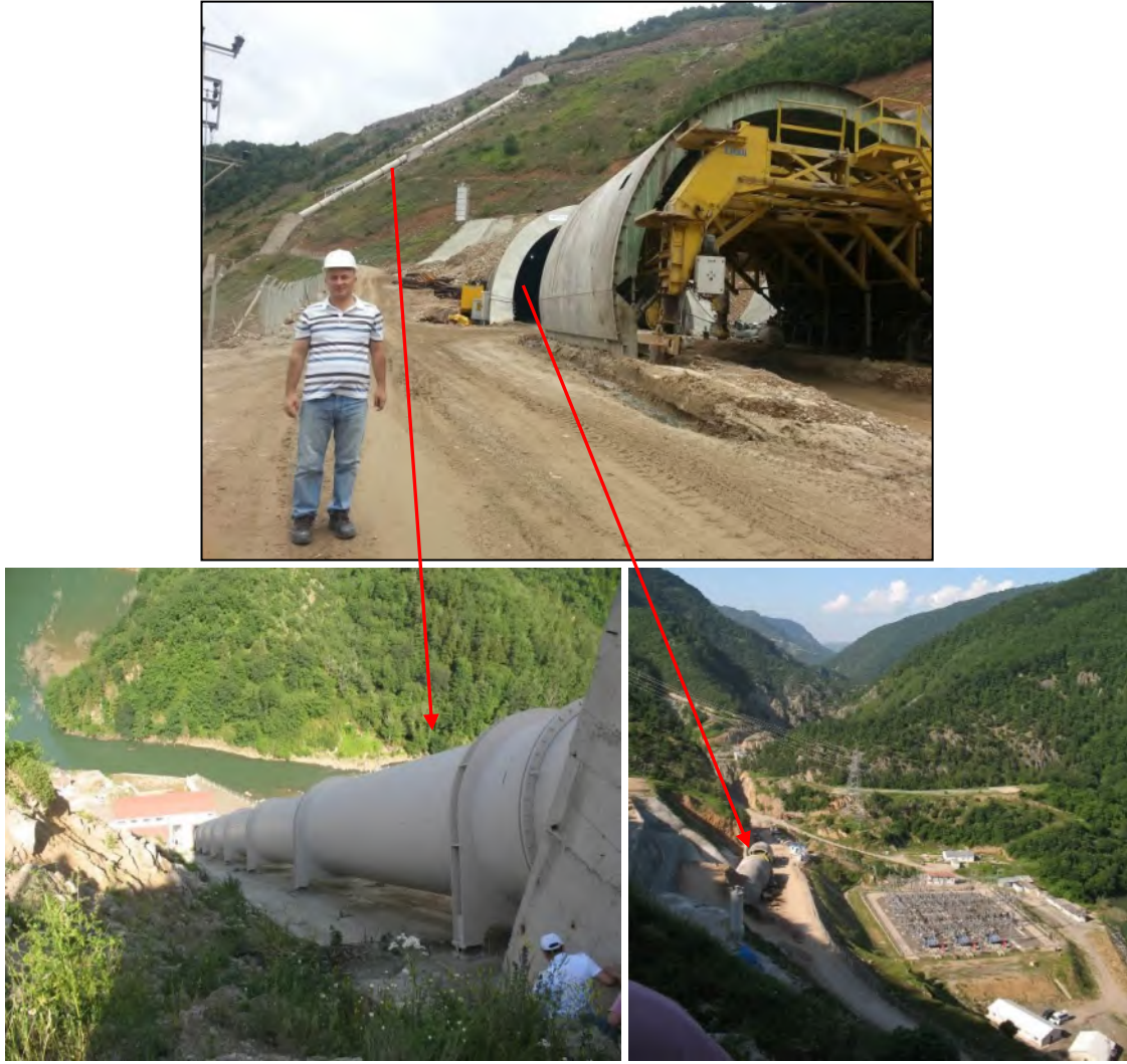
Şekil 1. Topçam T1 tüneli girişi (üstte), Topçam HES projesi cebri borusu (alt-sol) ve santral binaları
