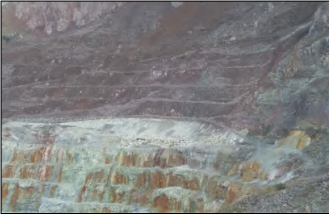
Şekil 11. Kesit-7 riskli bölge stabilize çalışması
