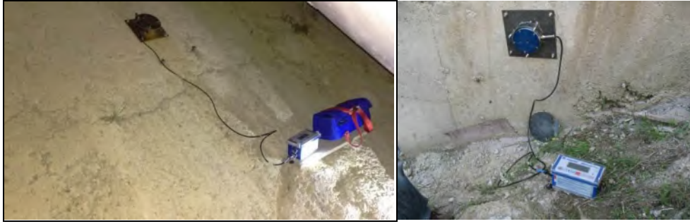
Şekil 3. Eğimli beton platform üzerinde ve su alma yapısı duvarında titreşim ölçümü
