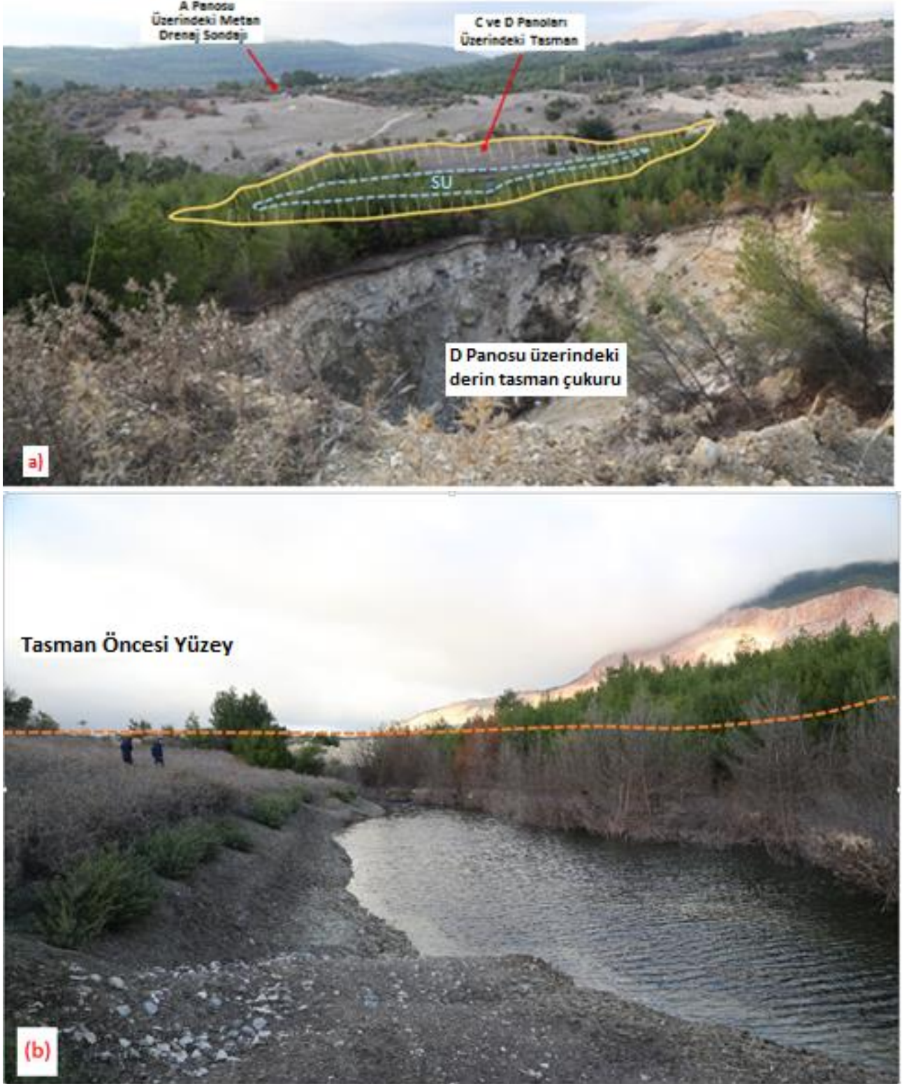
Şekil 13. a) D Panosu üzerindeki fay dokanağında bulunan derin tasman çukuru ve b) C ve D Panoları üzerindeki su dolu kama şekilli tasman oluşumu.
