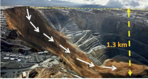
Şekil 18. 2013'te 1.3 km derinliğinde iken Bingham Canyon açık işletmesinde meydana gelen derin kayma (boing.boing.net/2013)
