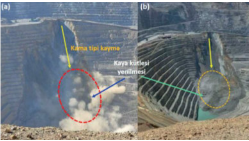
Şekil 7. Bingham Canyon bakır işletmesinde (Utah, ABD) (a) derin karmaşık duraysızlığın (31 Mayıs 2021) oluşum anına ve (b) kayma sonrasında ait görüntüler ( https://blogs.agu.org/landslideblog/2021/06/04/2021-bingham-canyon/ )
