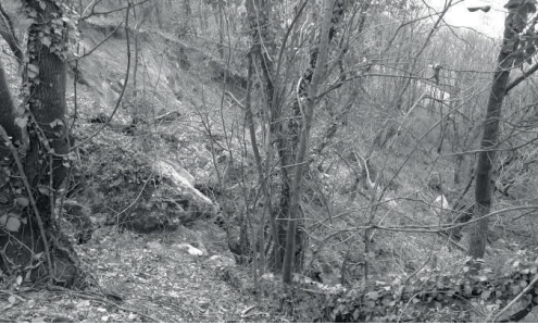
Şekil 3. Tünel güzergahı üzerinde mevcut sığ heyelanlardan bir görünüm
