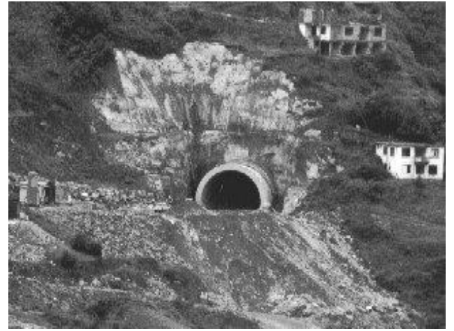
Şekil 2. Murgul Tüneli ön portalının genel görünüşü
