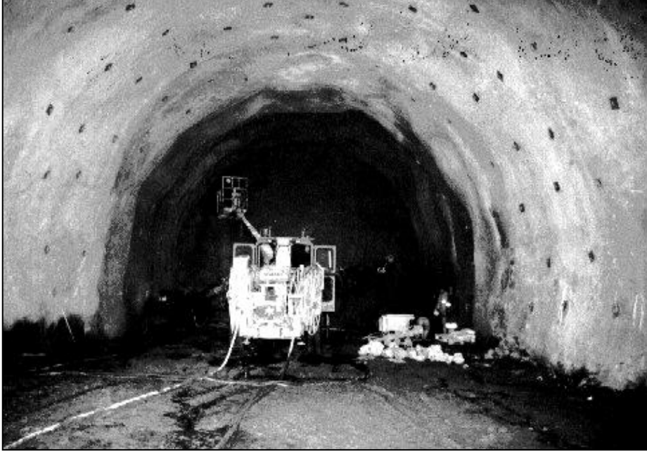
Şekil 6. Murgul Yolu tüneline kaya saplamalarının yerleştirilmesi
