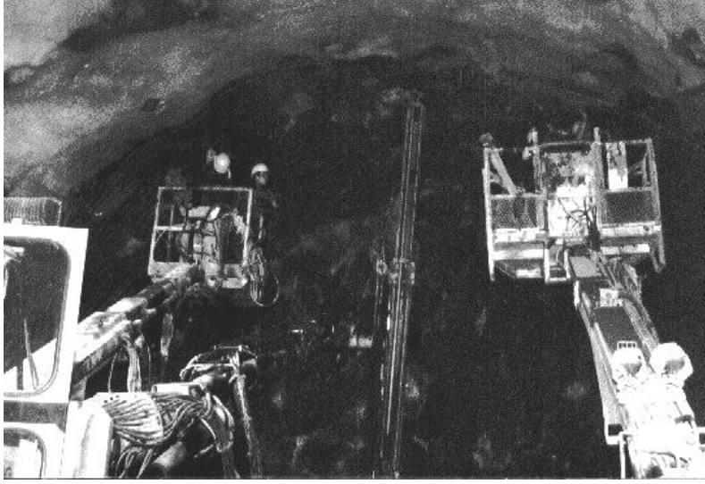
Şekil 5. Murgul tüneli aynasında delik açımı
