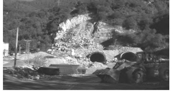
Foto 1. T nelin Sol T p Giriř Portalındaki Heyelan G r nt s 
