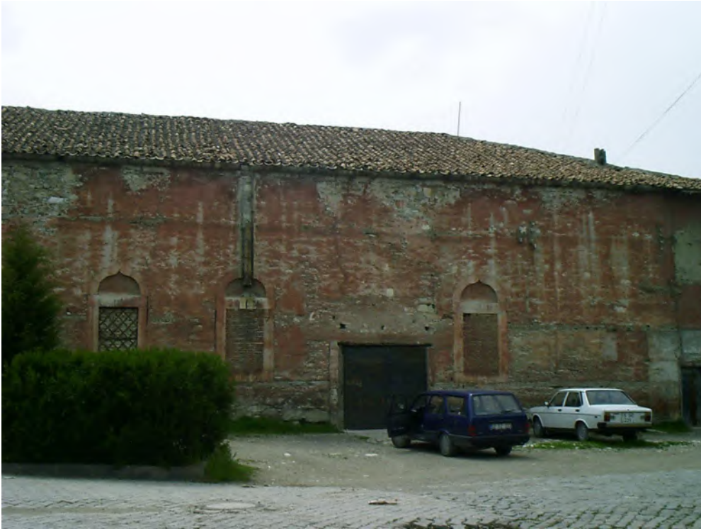
Şekil 3 Tarihi binalarda kullanılmış travertenlerin görünümü
