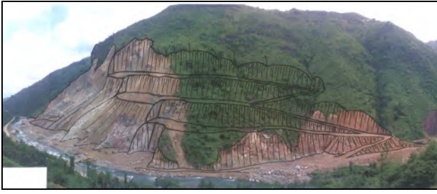
Şekil 25 Taş ocağında kademeli işletme sisteminin yerleştirilerek her kademelinin en üsteki kademe sahası en önde olacak şekilde tüm kademelerin ilerletilmesi
