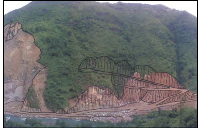
Şekil 18 Taş ocağında 2. kademe sahasının yerleştirilmesinin uygulaması
