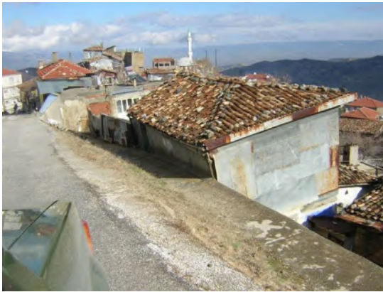
Şekil 2 Denizli-Babadağ İlçesi Gündoğdu Mahallesi'nde uzun süreli heyelandan dolayı yapılarındaki kaykılmalar ve değişik zamanlarda yapılan yol dolgu kalınlıklarındaki değişimler
