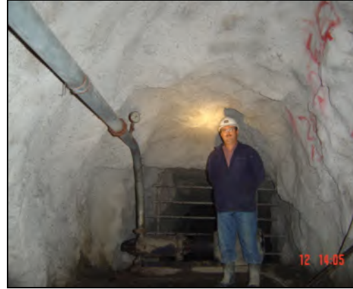
Şekil 5 -260 katı ana nakliye galerisi püskürtme beton uygulama örneği
