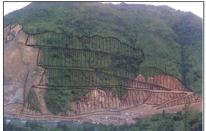
Şekil 24 Taş ocağında 3. kademe sahasının ilerletilerek 2. kademe sahasının önünde yer alması
