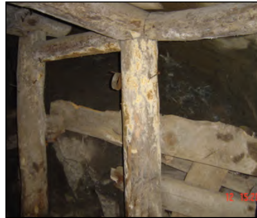
Şekil 2 Çürümeye başlamış ağaç tahkimat elemanları
