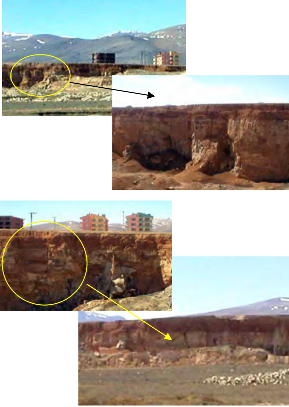
Şekil 7 Konya şehir merkezinin kuzey doğusunda, yerleşime yeni açılan, Selçuklu ilçesi, Binkonutlar mahallesinde 3, 5 ve 8 katlı binaların yapıldığı temeller. Tabandaki çatlaklı, kristalize kireçtaşları üzerinde 1-5 m kalınlığında toprak (kil) bulunmaktadır
