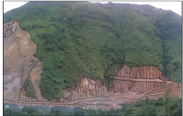
Şekil 9 Taş ocağında 1. kademe sahasının oluşturulması
