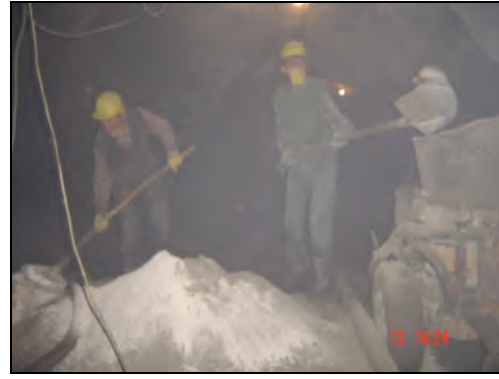
Şekil 4 Yeraltında gunit katılması ve makineye besleme
