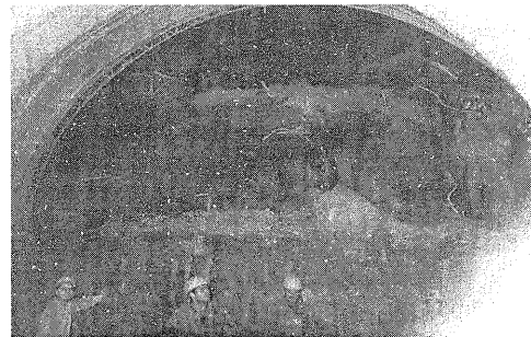
Şekil 2. Yenikapı bölgesinde Hat 1 tüneller aynasında karşılaşılan Güngören kili
