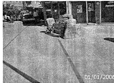
Foto 4. Andezit, traki-andezitlerin kaplama taşı olarak kullanımı
