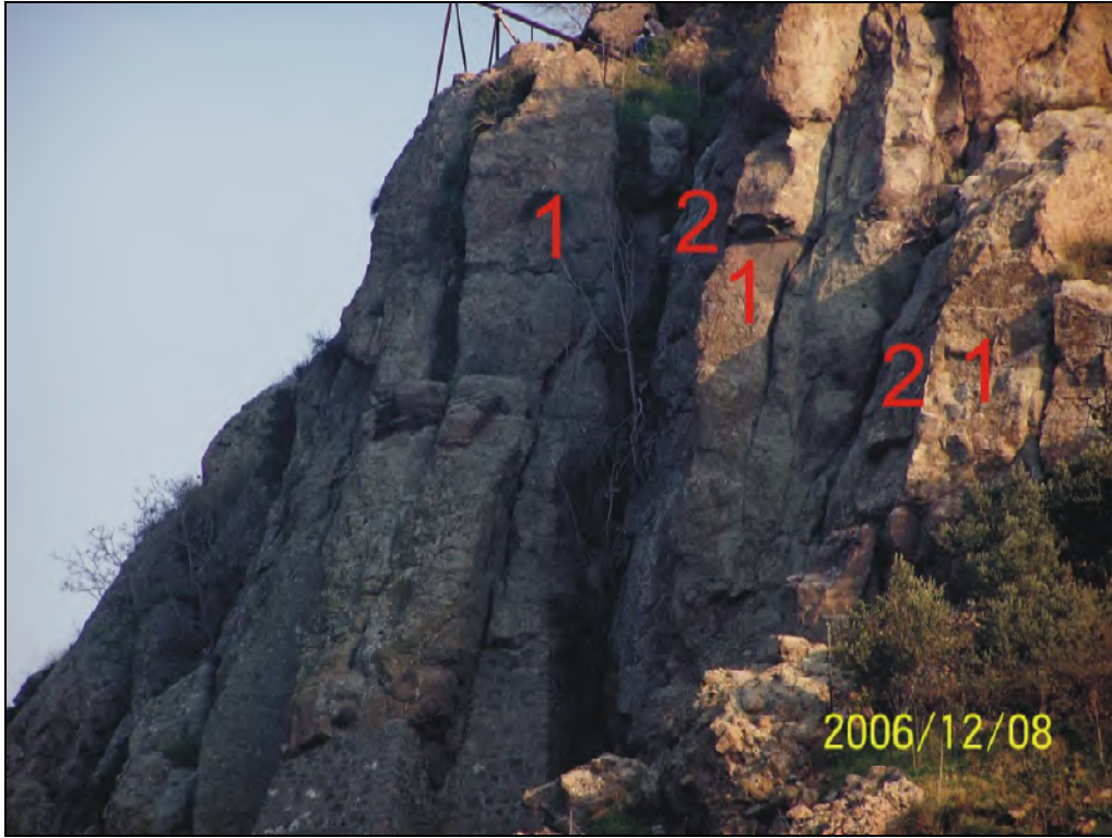
Şekil 11 : Stabilitesi incelenen andezit kaya şevi ve iki yönde gelişmiş soğuma yüzeyleri (1 ve 2 : soğuma çatlak takımları).
