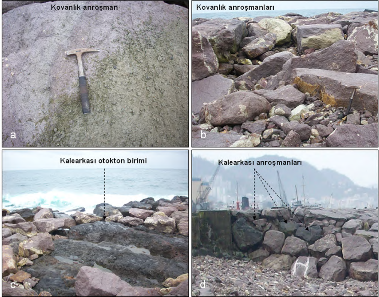
Şekil 2. (a) Kovanlık anroşmanlarında killeşme ve (b) ufalanma: (c) Giresun limanının ilk yapıldığı zeminde bulunan Kalearkası otokton birimi (d) 1999 Fırtınasından sağlam kalan Kalearkası anroşmanlarının genel görünümü
