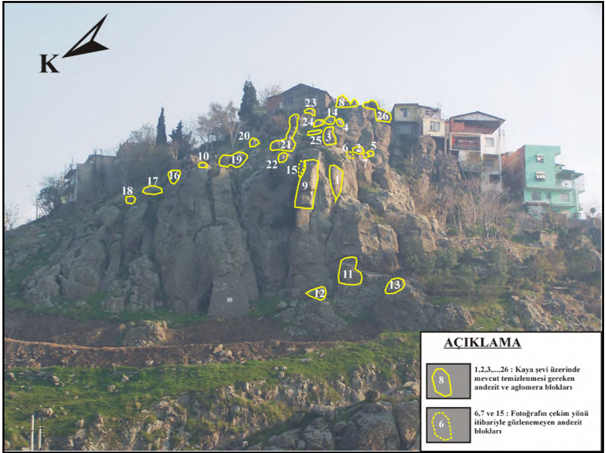
Şekil 17: Şevin temizlenmesine yönelik stabilite açısından riskli kaya bloklarının lokasyonları (Fotoğraf, kuzeybatıdan güneydoğuya doğru bakılarak çekilmiştir).
