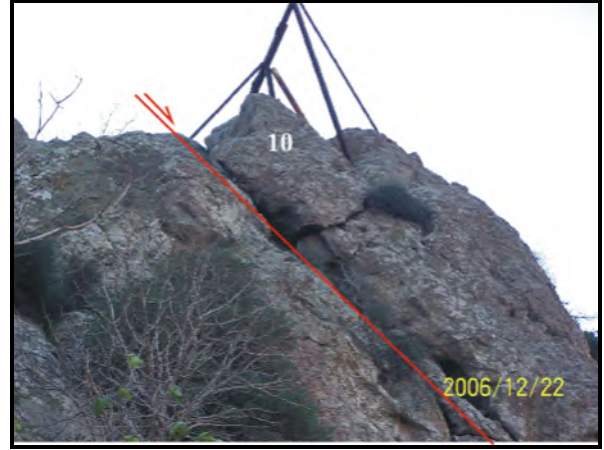
Şekil 13: 10-nolu kaya şevinden görünüm.
