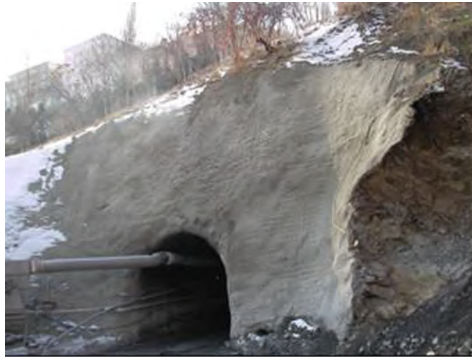
Şekil 6. Dikmen Vadisi'nde açılmakta olan atık su tünelinin yaklaşımı.
